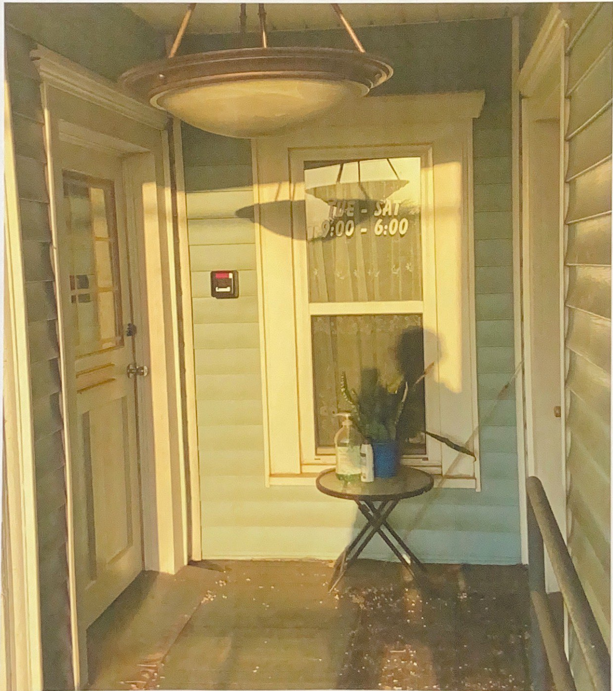
Future Entry Door
